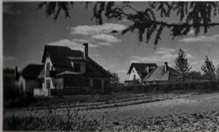
Коттеджи для проживания сотрудников Биостанции.
